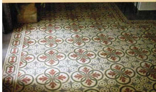
In den traditionellen Zementfliesen wird Marmor­mehl verwendet
